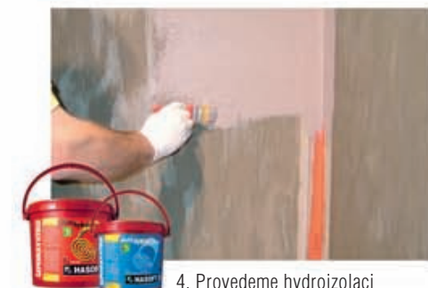
4. Provedeme hydroizolaci LEPENKOU V KÝBLU
