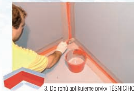
2. Všechny rohy vytmélíme ve vlhku rozpínavým TĚSNIČEM tmelem
