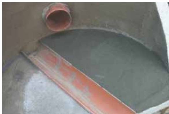
Obr. 2 - Monolitické rychleschnoucí šachtové dno
