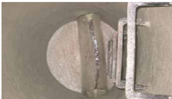
Obr. 5 - Finalizovaný povrch šachty ochranným nátěrem
