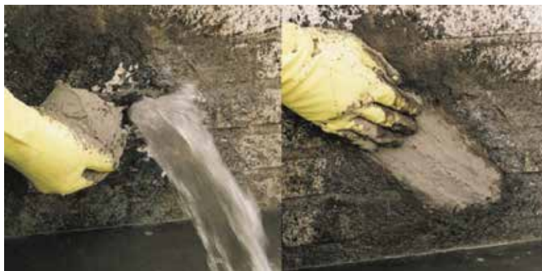
Obr. 6 - Zastavení průsaku těsnicím pudrem Puder-Ex
