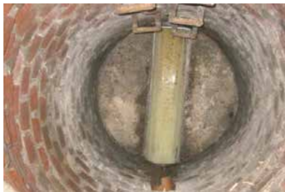
Obr. 4 - Zděné objekty na stokové síti
