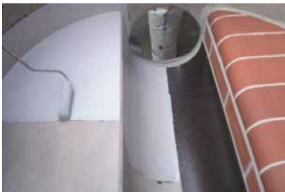
Obr. 3 - Finalizovaný povrch šachtového dna ochranným nátěrem
