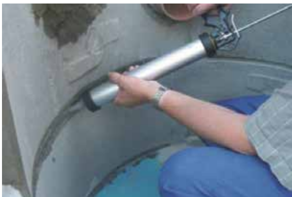
Obr. 1 - Těsnění pracovních spár
