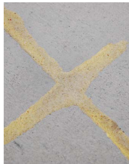
✓ Správné provedení sanace trhlin
