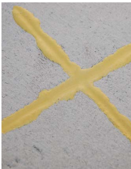
✗ Nedostatečné provedení sanace trhlin
