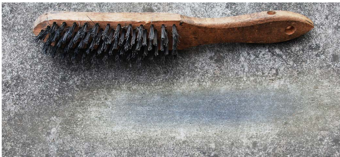
Správně provedená zkouška ocelovým kartáčem
