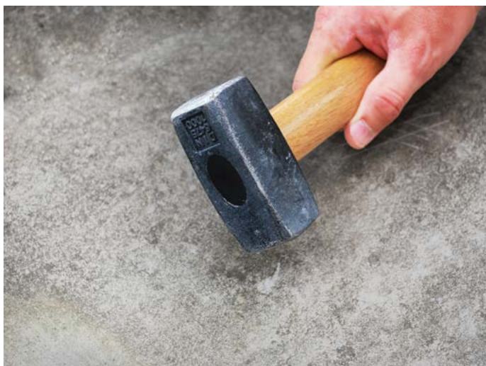
Správně provedená zkouška kladivem
