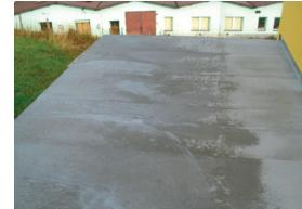
na dôkladne očistenú a napenetovanú podkladovú konštrukciu pomocou flexibilného lepidla DLAŽ-BULEP alebo SIMSONTOPU nalepíme SPÁDOVÉ KONŠTRUKČNÉ DOSKY
