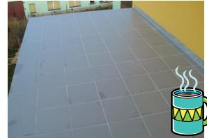
lepenie dlažby vykonávame kombinovaným spôsobom a s presahom dlažby cez okraj BALKÓNOVÉHO PROFILU cca 5 mm
