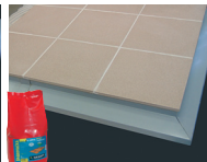
Na zaschlý povrch hydroizolace přilépíme dlažbu DLAŽBOLEPEM a zospojíme SPÁROVAČKOU
