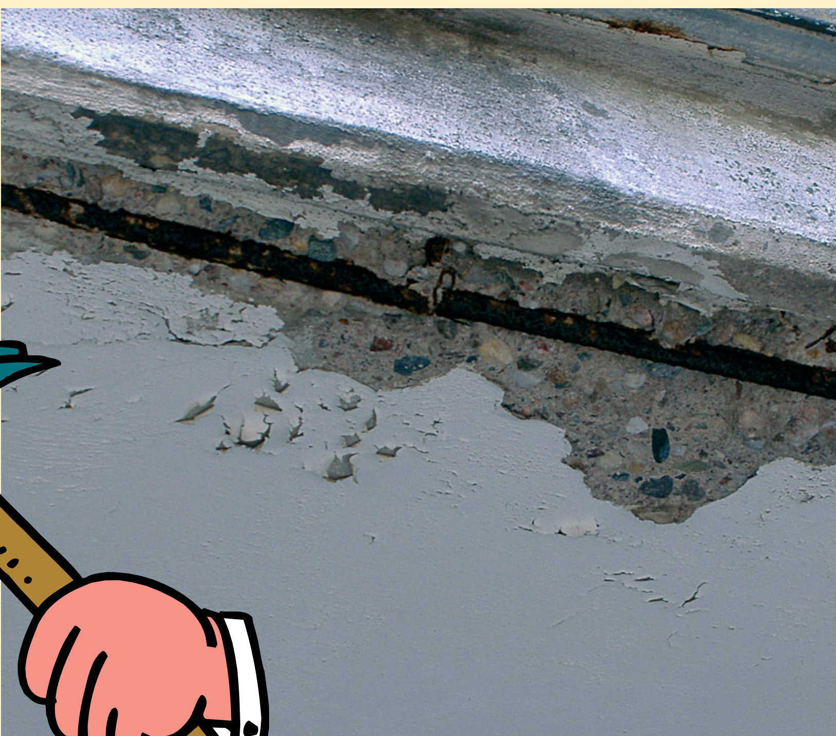
Očistíme ocelovou výztuž
