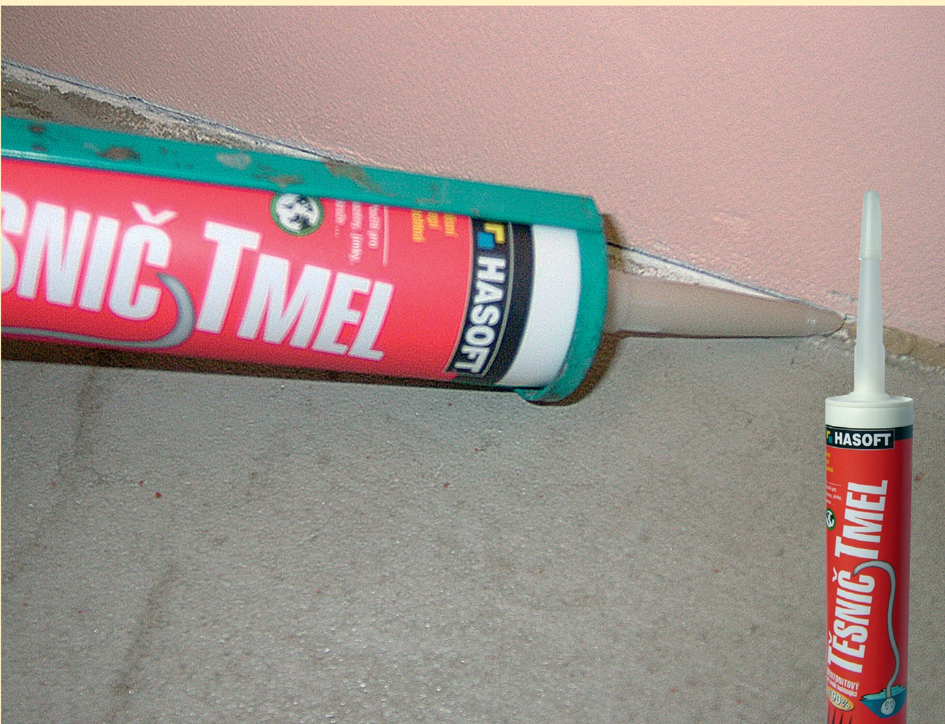
Rohy, dilatační spáry a styk vodorovné a svislé konstrukce doporučujeme vyplnit tmelem TĚSNIČ
