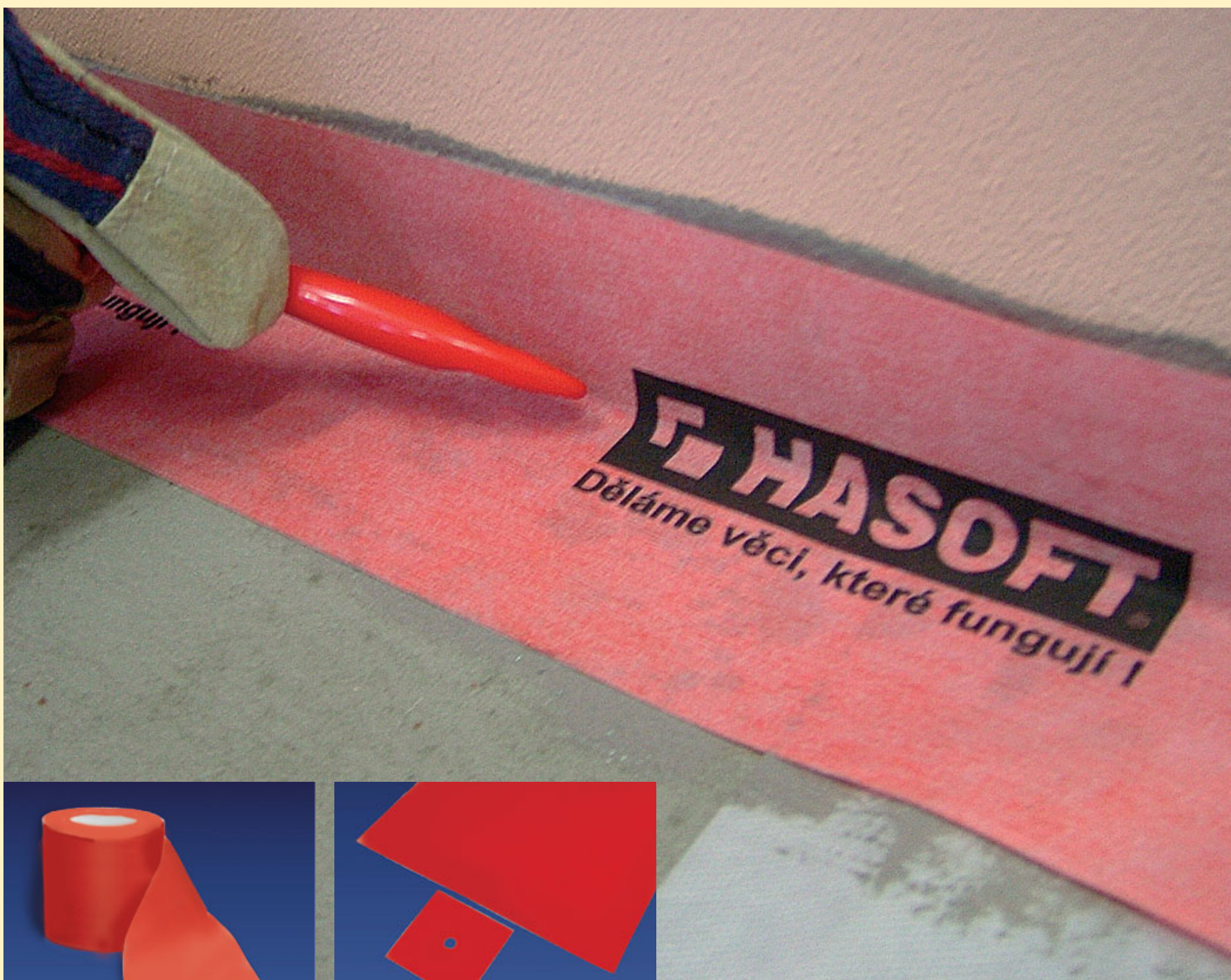
Do "živé" LEPENKY V KÝBLU zakotvíme prvky TĚSNICÍHO SYSTÉMU a důkladně vtlačíme do hydroizolace, nejlépe tupou stranou štětce
