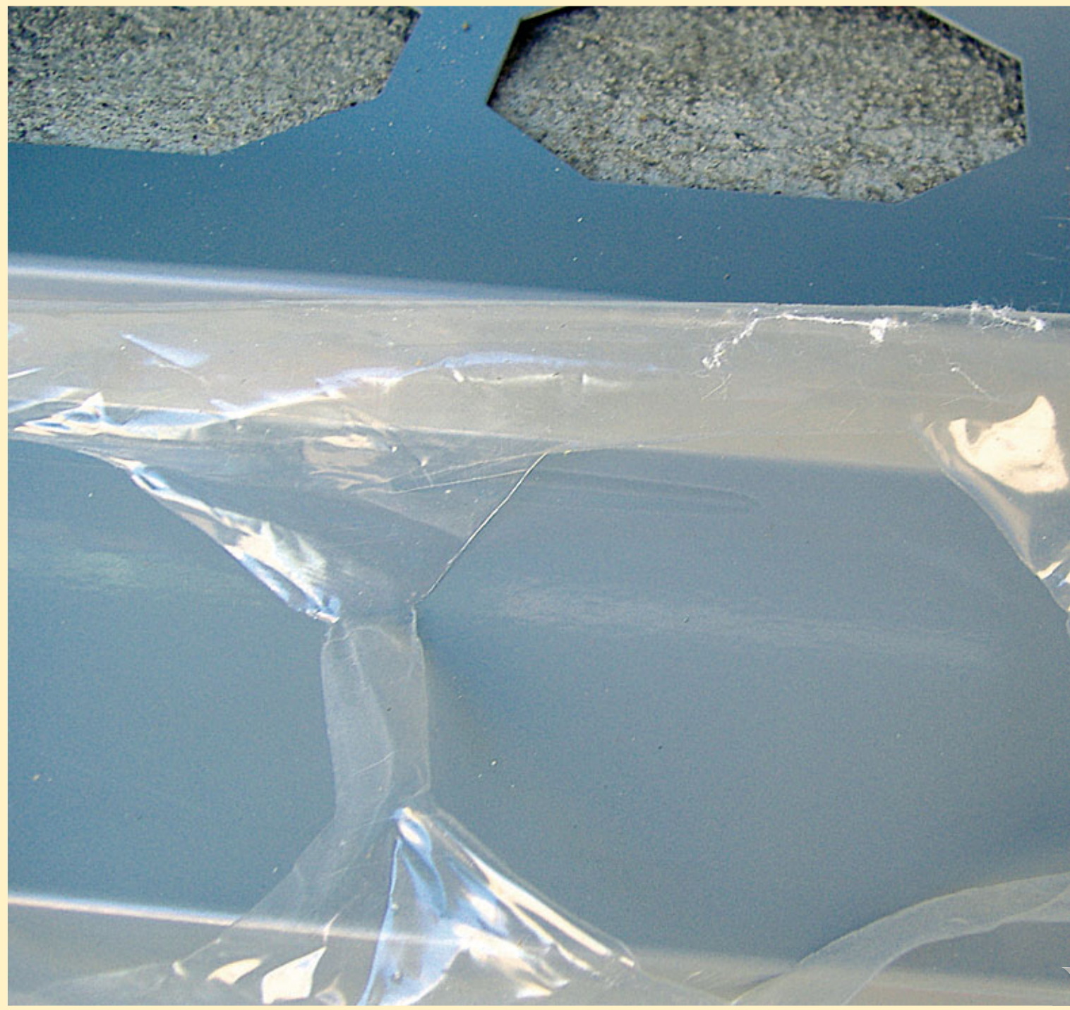
Stáhneme ochrannou fólii z perforované oblasti a na zbytku ji ponecháme, aby se BALKÓNOVÝ PROFIL nepoškodil LEPENKOU V KÝBLU, popřípadě dalšími aplikovanými materiály
