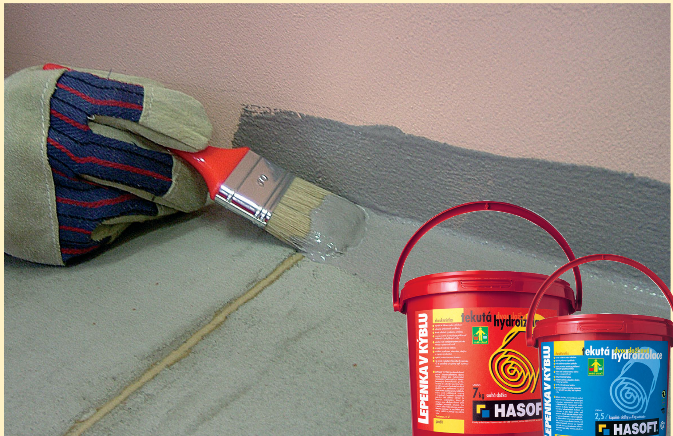
Po zaschnutí provedeme podnáťěr těchto partií LEPENKOU V KÝBLU
