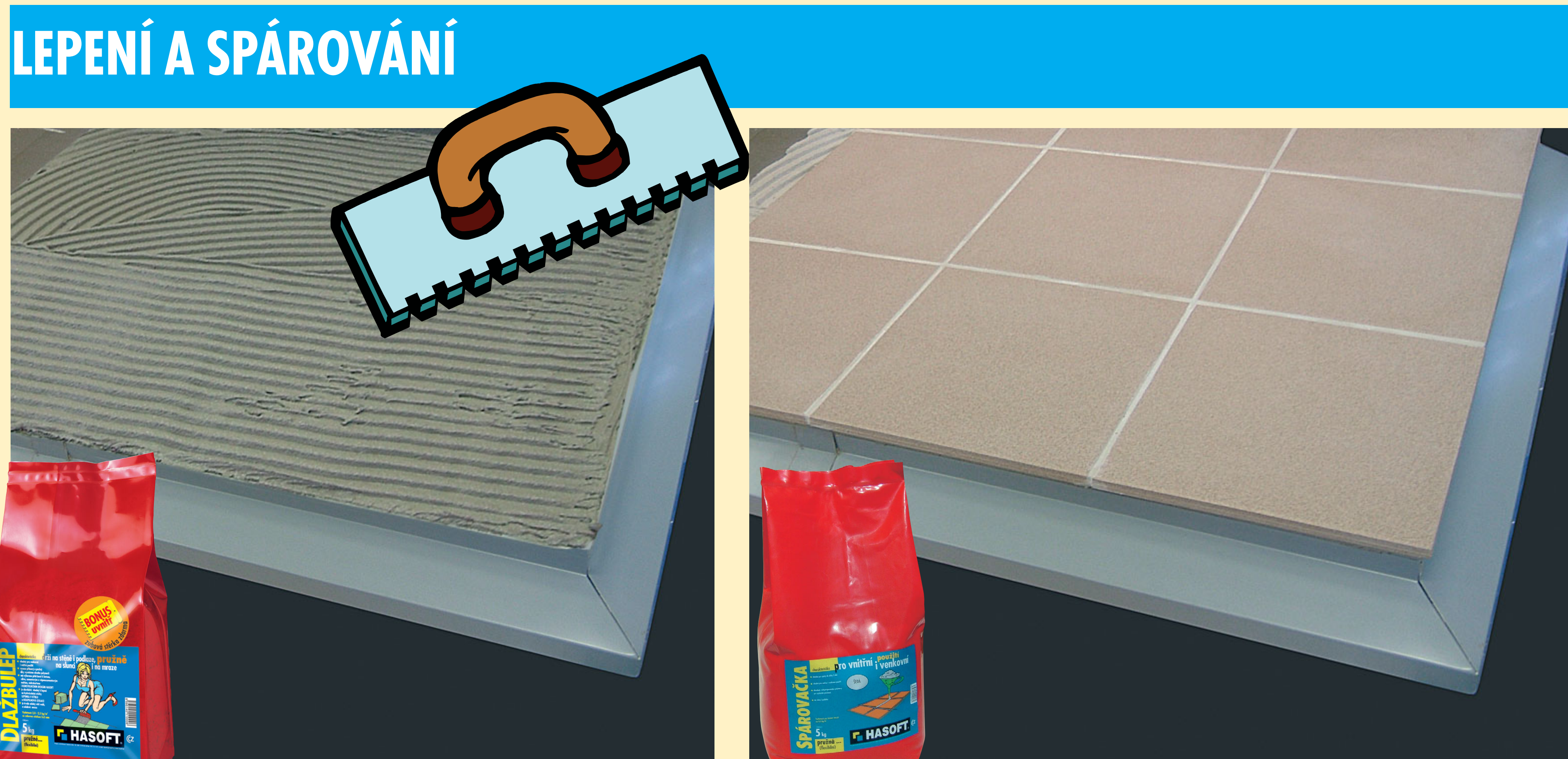
Na zaschlý povrch hydroizolace přilepíme dlažbu DLAŽBULEPEM a zaspárujeme SPÁROVAČKOU
