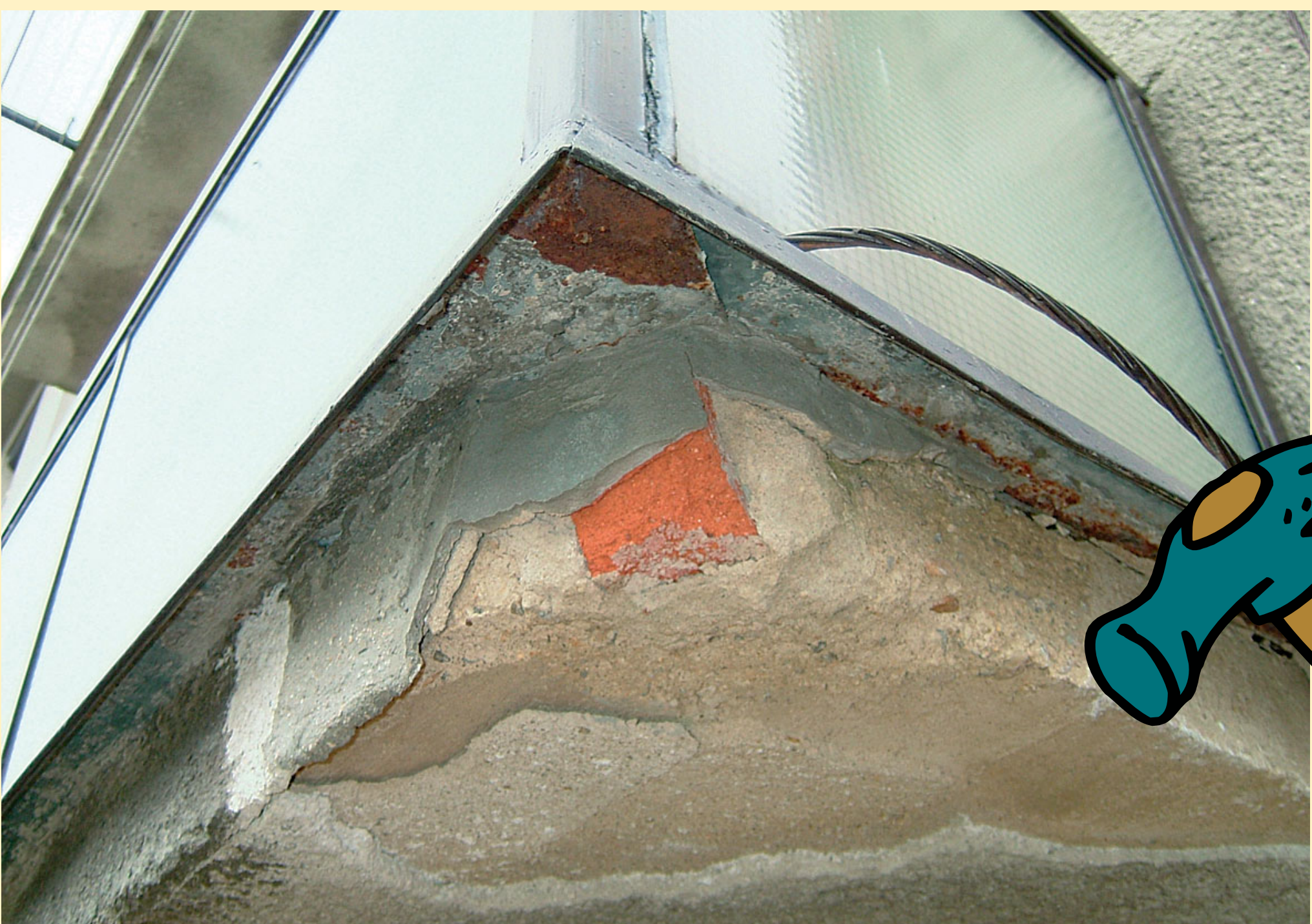
Důkladně očistíme podkladní konstrukci od nesou-
