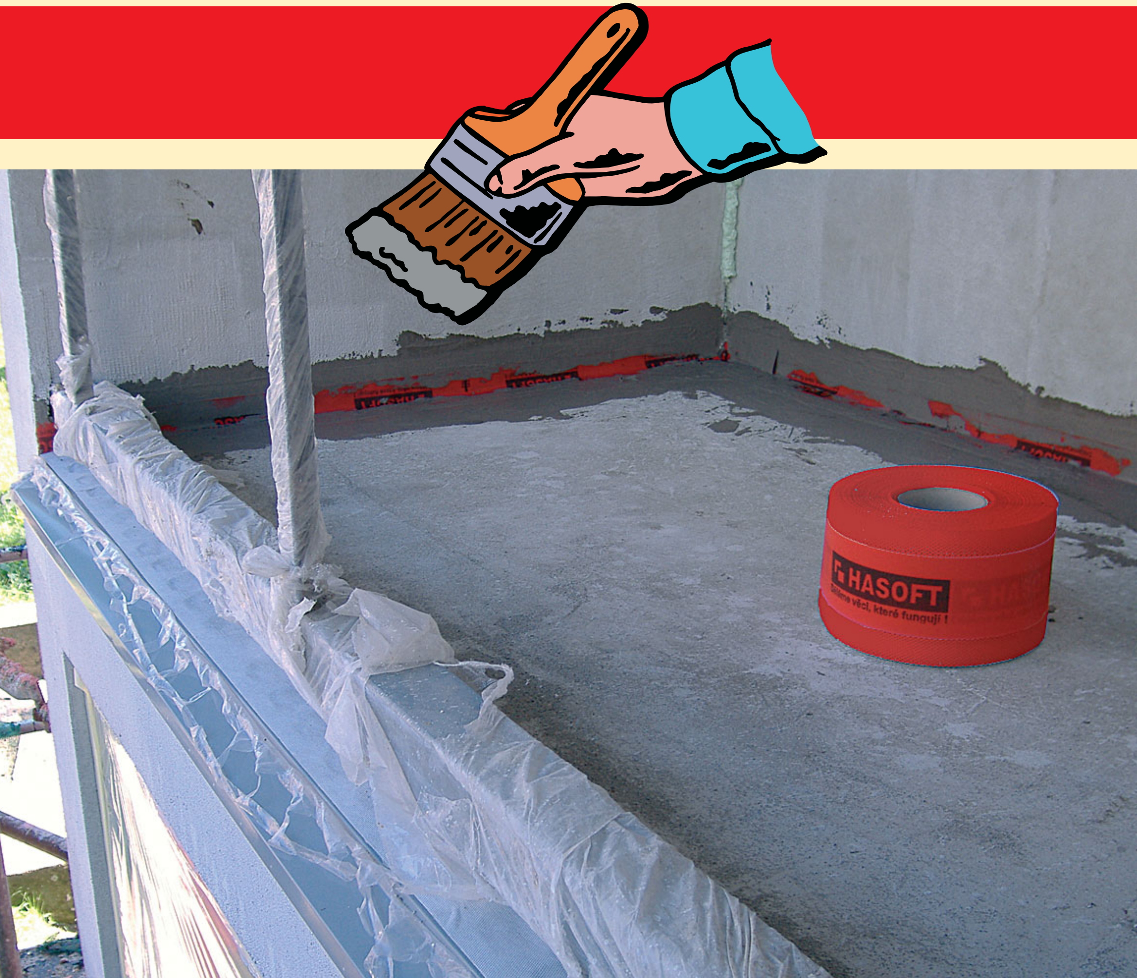
Provedeme celoplošný nátěr hydroizolací LEPENKA V KÝBLU
