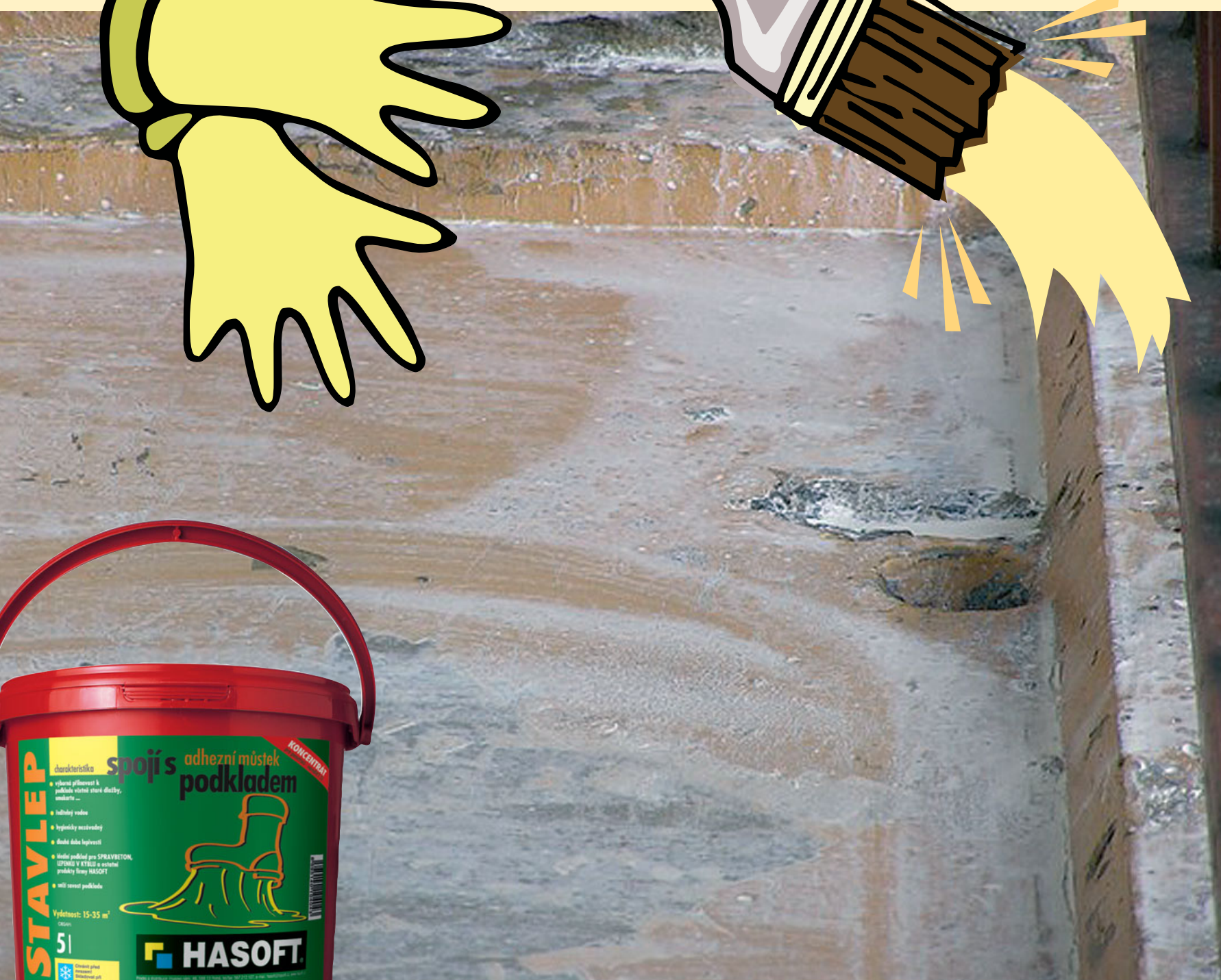
Na opravované plochy a obnaženou ocelovou výztuž naneseeme adhezní můstek STAVLEP
