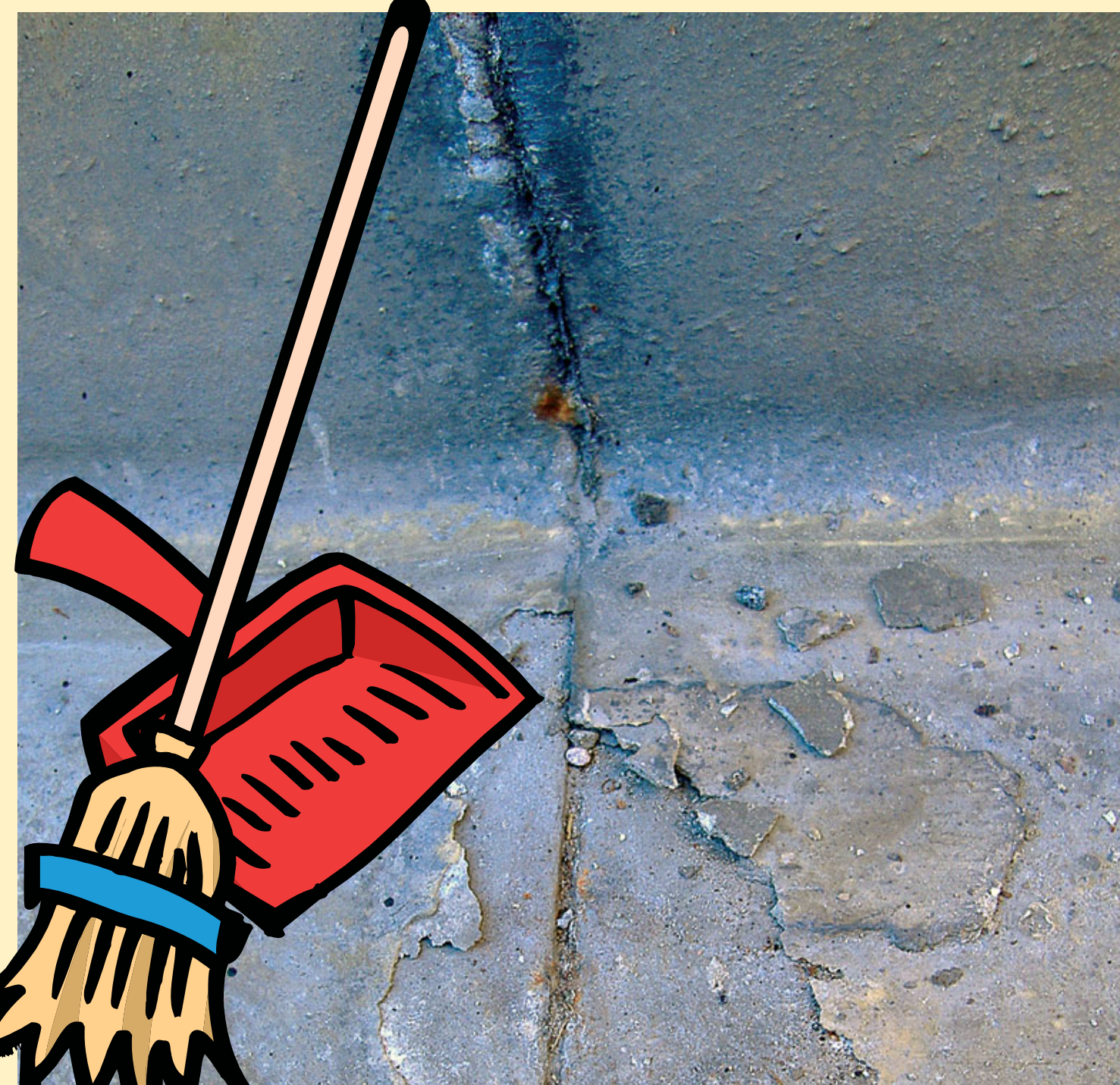
Zameteme nebo ještě lépe vysajeme povrch a vyčistíme dilatační spáry
