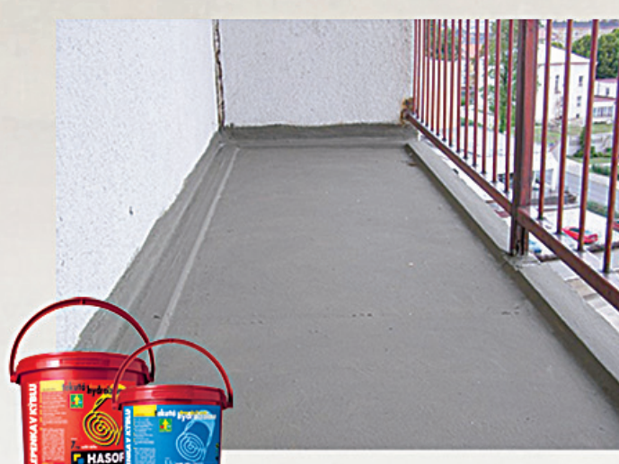
4. Provedeme hydroizolaci LEPENKOU V KÝBLU
