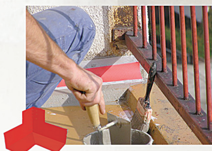
3. Do rohů aplikujeme těsnicí pás
