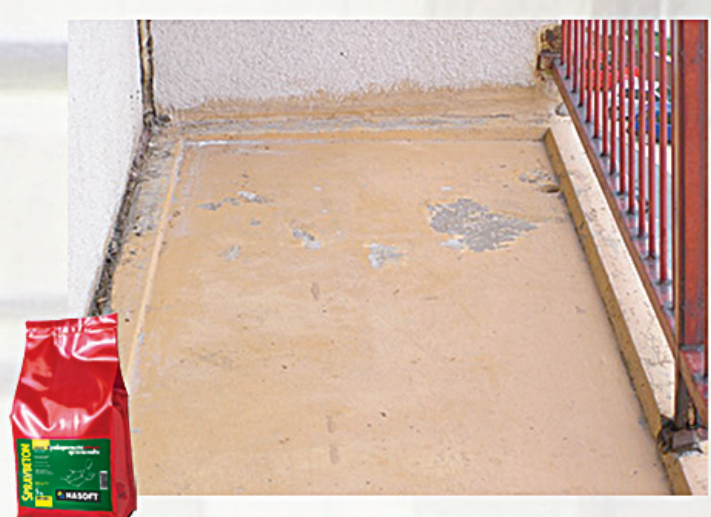
1. Povrch dokonale očistíme a díry vyspravíme SPRAVBETONEM
