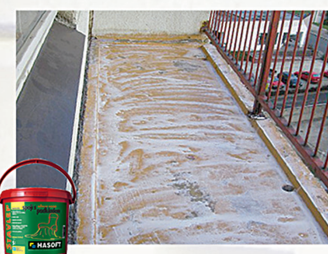
2. Povrch natřeme adhezním můstkem STAVLEP
