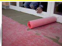
Do vrstvy lepidla pokládáme s přesahem 10 cm
