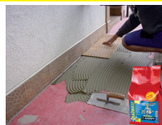
Naneseme DLAŽBULEP a pokládáme dlažbu
