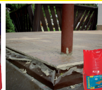
Zbývá zaspárovat SPÁROVAČKOU
