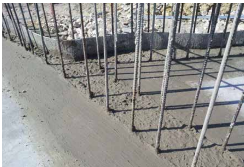
Obr. 5 - Izolace základové desky
