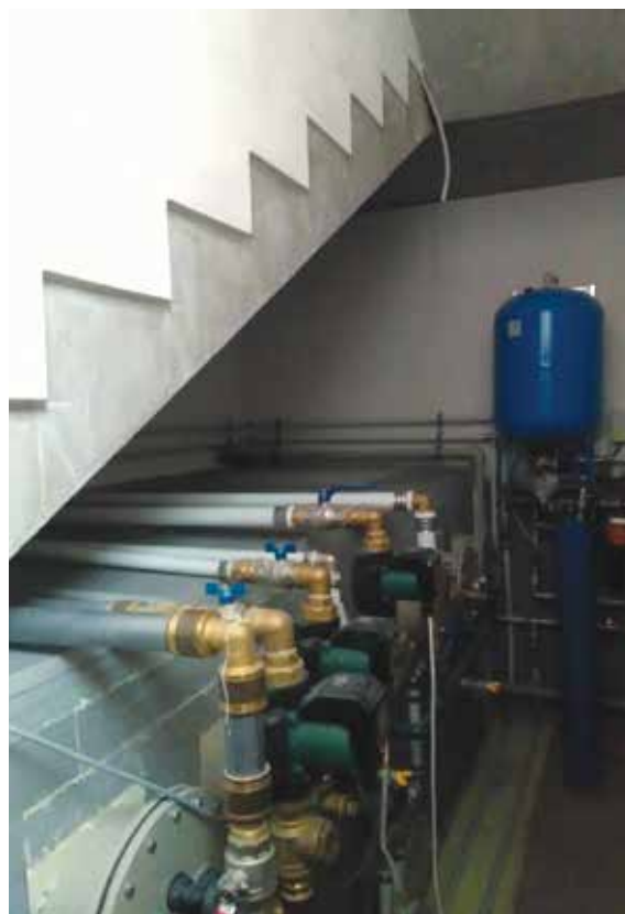
Obr. 4 - Strojovna pod úrovní terénu po 5 letech užívání
