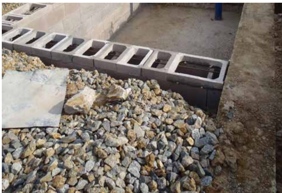
Obr. 1 - Nosná konstrukce strojovny pod úrovní terénu
