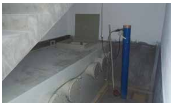
Obr. 3 - Utěsnění konstrukce strojovny pod úrovní terénu
